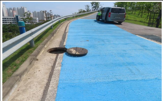
송수-3 종점부 전경
