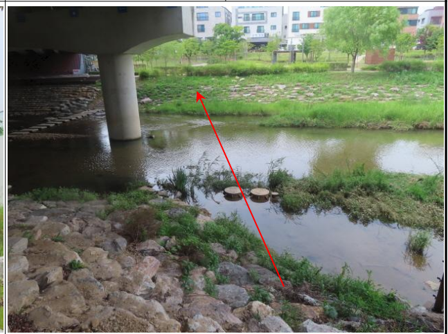
송수-4, 5 (Sta.315+6.0, Sta.36+16.0)
