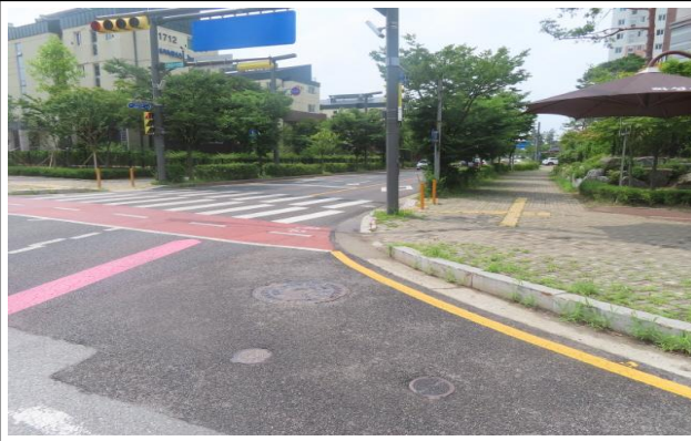
송수-6 시점부 전경
