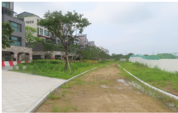
송수-4, 5 시점부 전경
