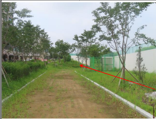
송수-4, 5 (Sta.282+0.0, Sta.3+10.0)
